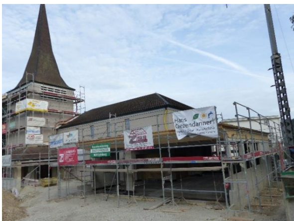
Kirche im Umbau
